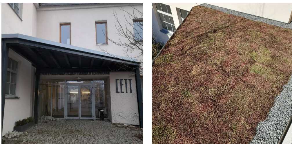
Obrázek 9 Zelená střecha CETT - stav ihned po založení, podzim 2022
